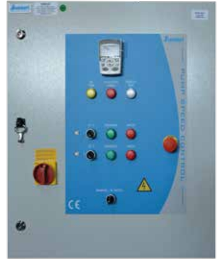
Resim 2 : İki pompalı frekans kontrollü panonun önden görünüşü
